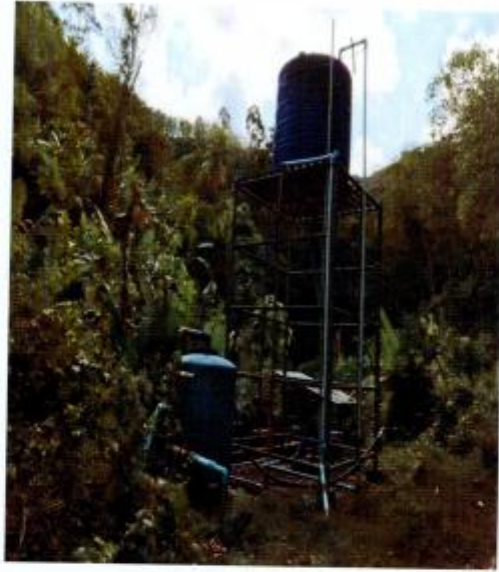
รูปภาพระบบประปาแบบฝักบัวบ้านห้วยบ่อจันทร์ (โครงถัก) หมู่ที่ ๗
