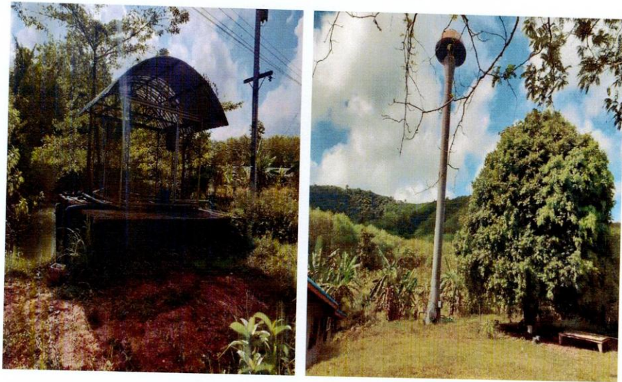
รูปภาพระบบประปาแบบฝิวดินบริเวณบ้านนายช่วง (แบบถังแชมแปน) หมู่ที่ ๘
