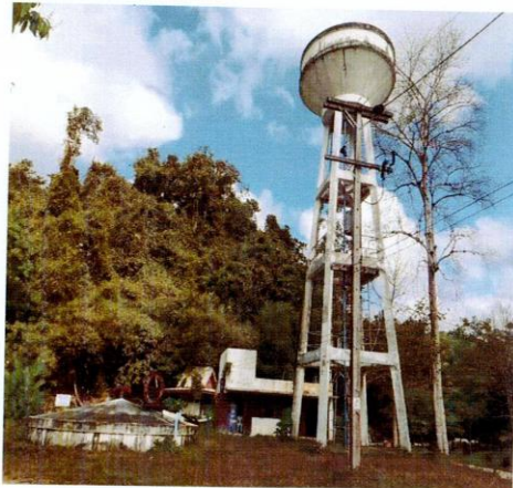
รูปภาพระบบประปาผิวดินบ้านนพเขาเทริก หมู่ที่ ๓
